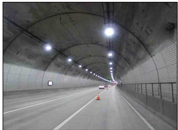
c. 터널 내부 전경
