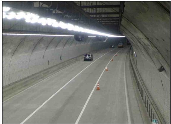
i. 2023년 터널 내부 현황(변상 및 추가시설 없음)
