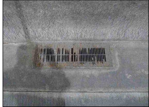
b. 배수시설 집수구 전경
