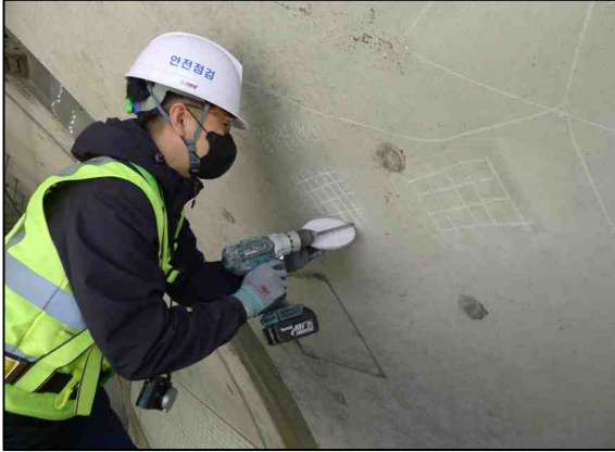
a. 탄산화시험부 부재 천공 현황
