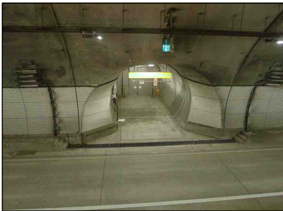
b. 피난연락갱(차량용) 전경(Span 54)
