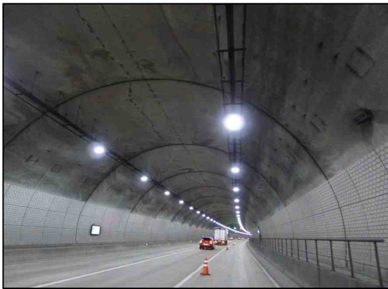
a. 콘크리트 라이닝(천단부) 전경
