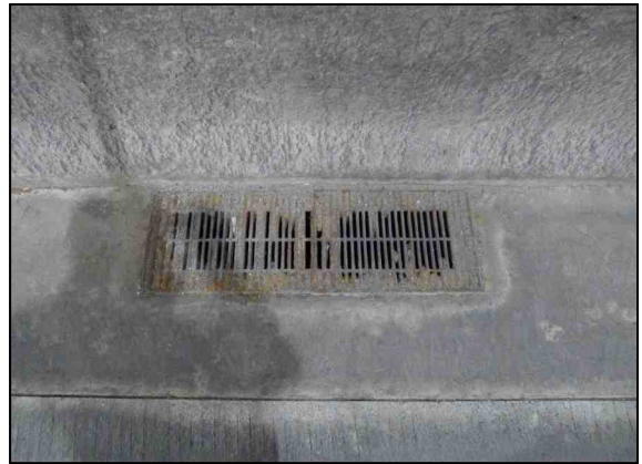
d. 배수시설 상태양호
