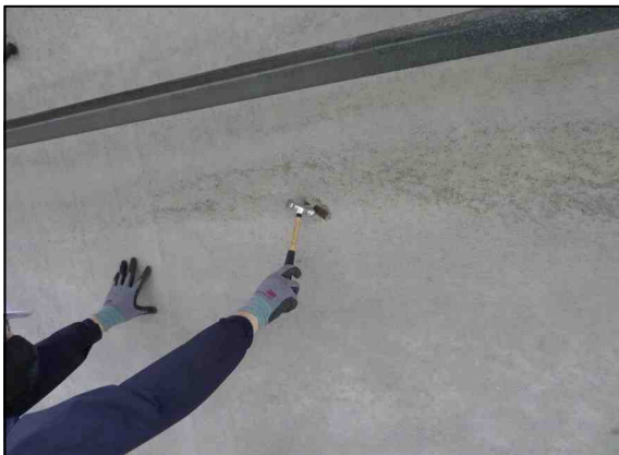
c. 점검망치를 이용한 라이닝 외관조사현황
