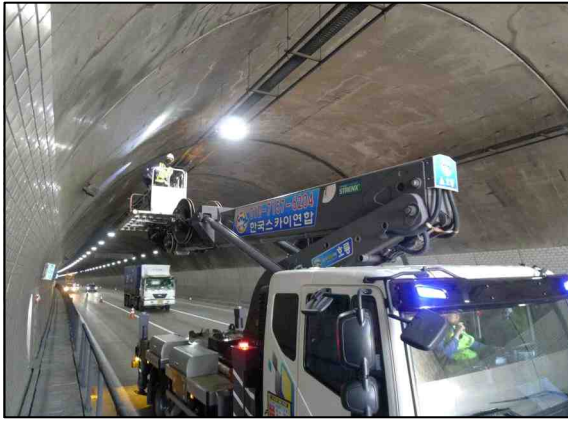
a. 고소작업차량을 이용한 천단부 외관조사현황①
