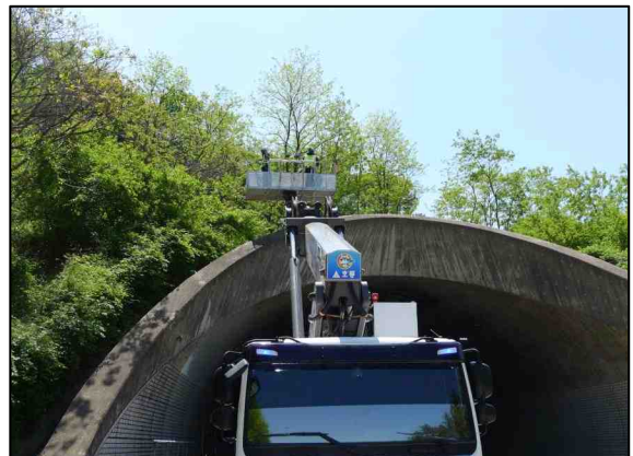
d. 고소작업차량을 이용한 갱구부 외관조사현황
