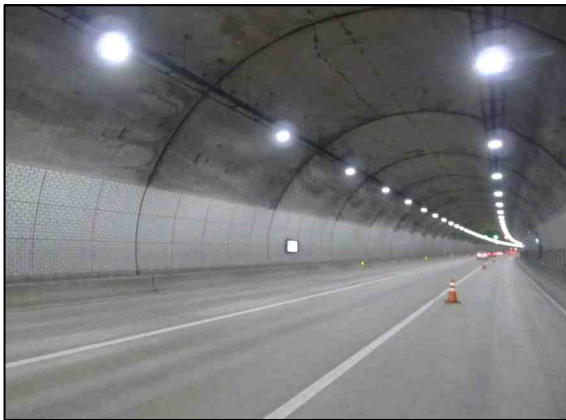
c. 콘크리트 라이닝(측벽부) 전경
