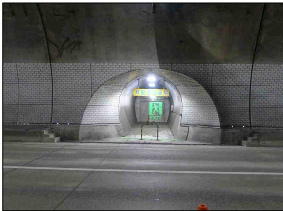
a. 피난연락갱 S91(인도용) 상태양호
