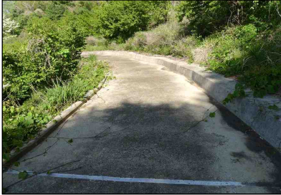
a. 시점 소단 배수로 전경
