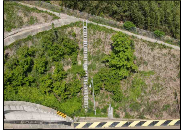
b. 사면 내 점검계단 상태양호
