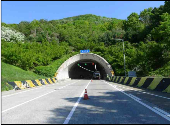
a. 시점부 갭문 상태양호
