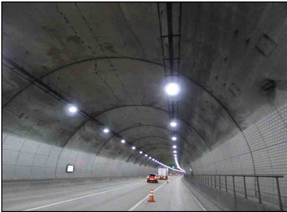
c. 천단부 상태양호(누수 없음)
