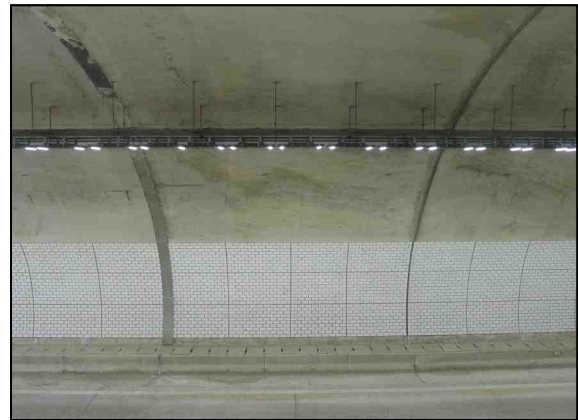
d. 측벽부 타일 시공현황
