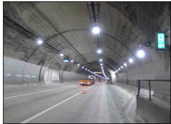
b. 단면변화부(Span. 126~130 비상주차대) 전경
